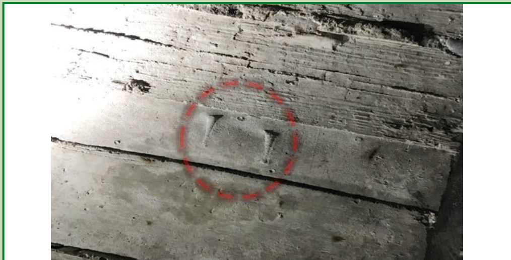
Bild 1: Visuell sichtbarer Abstandhalter an der Unterseite einer Stahlbetondecke Quelle: Wessling GmbH
