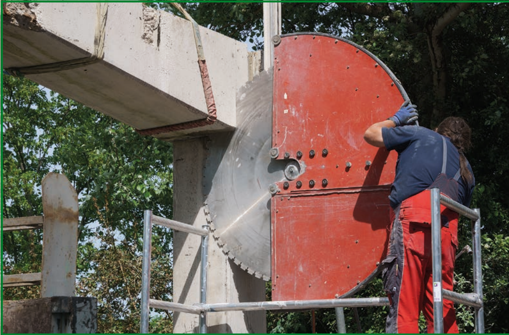
Bild 1: Selektiver Rückbau mit einer diamantbestückten Beton- säge als Konzeptnachweis für die Gewinnung von Betonteilen zur Wiederauf- bereitung und Wiederver- wendung als Fertigteile 2.0. Quelle: Malcolm Unger, DDU, TU Darmstadt
