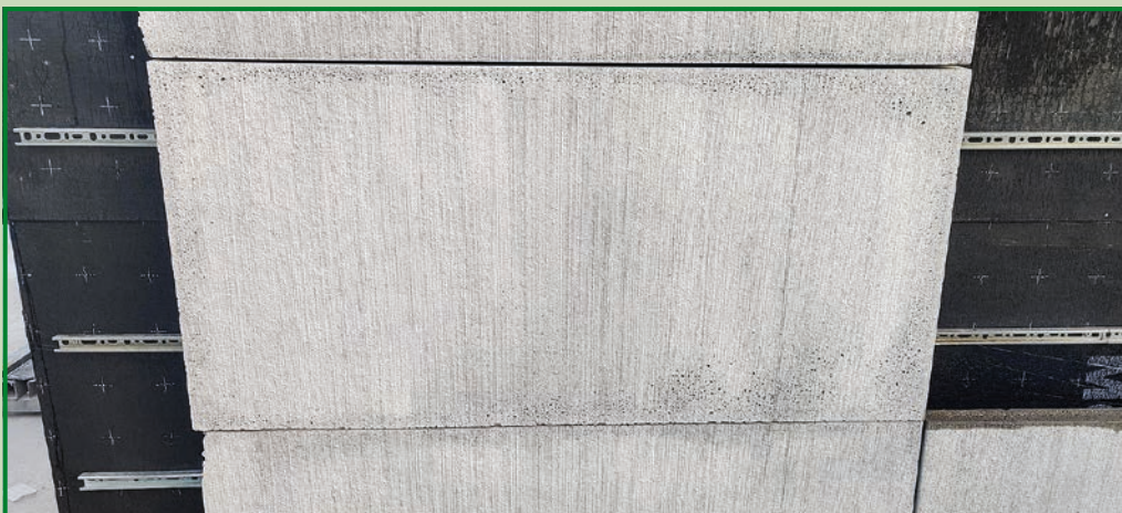
Bild 2: Leichtbetonfassaden- platten aus Infraleichtbeton als Demonstrator Foto: Beton- und Naturstein Babelsberg GmbH
