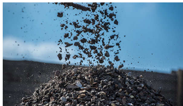
Mechanische Aufbereitung von Recyclingbaustoffen
